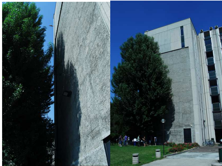
Figure 8 The Edificio 21 test façade.
